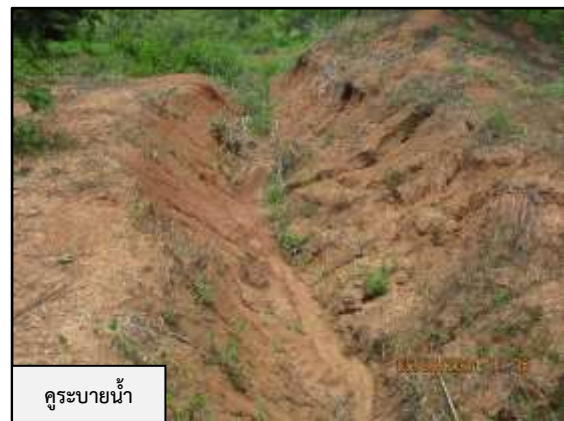
ภาพที่ 3.33 คันดินและคูระบายน้ำพื้นที่โครงการ
